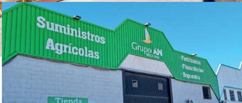
Nuevo almacén con tienda y oficina en Bedmar, Jaén
