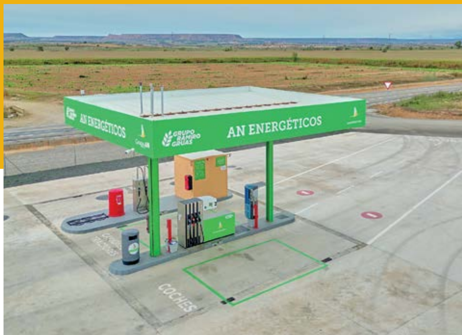
Nueva gasolinera en Estiche de Cinca, Huesca
