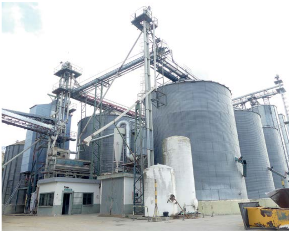
Silos de almacenamiento de arroz en la Cooperativa San Esteban de Arguedas
