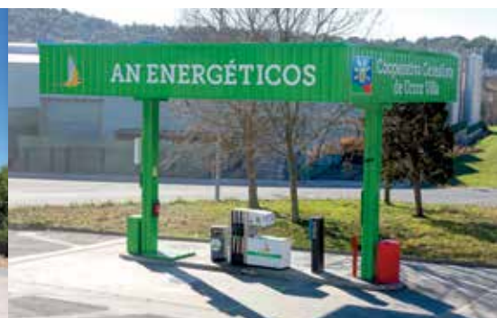
Estación de servicio en Egüés, en Navarra
