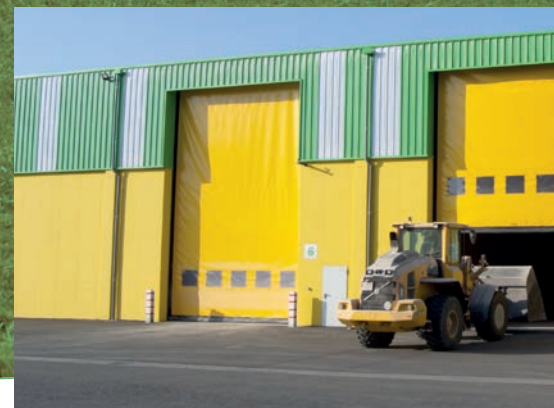
Nuevas puertas con apertura automática en el almacén de Tajonar
