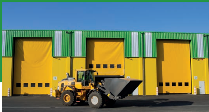
Nuevas puertas automáticas del almacén de Tajonar
